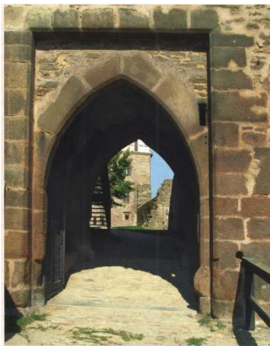
Lipnice nad Sázavou - brána, první polovina 14. století
