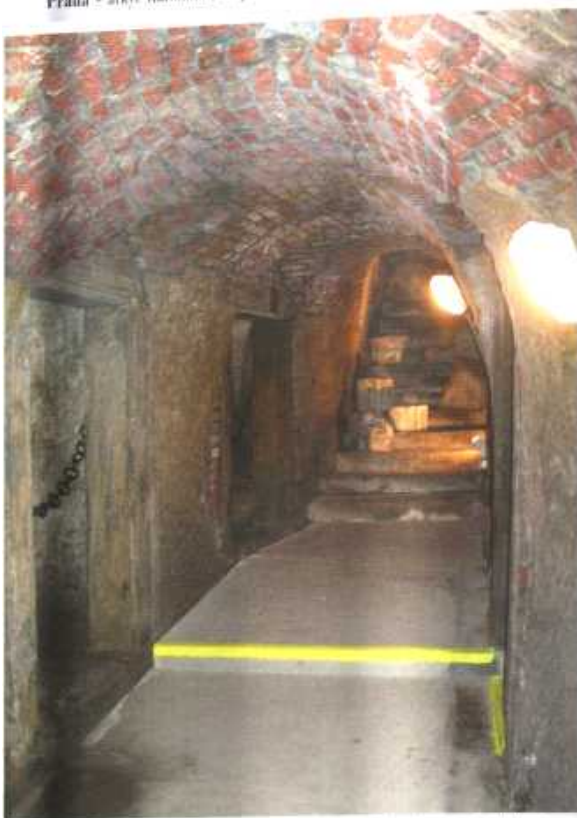
Písek - dochované sklepy a podzemní chodby středověkých měšťanských domů
