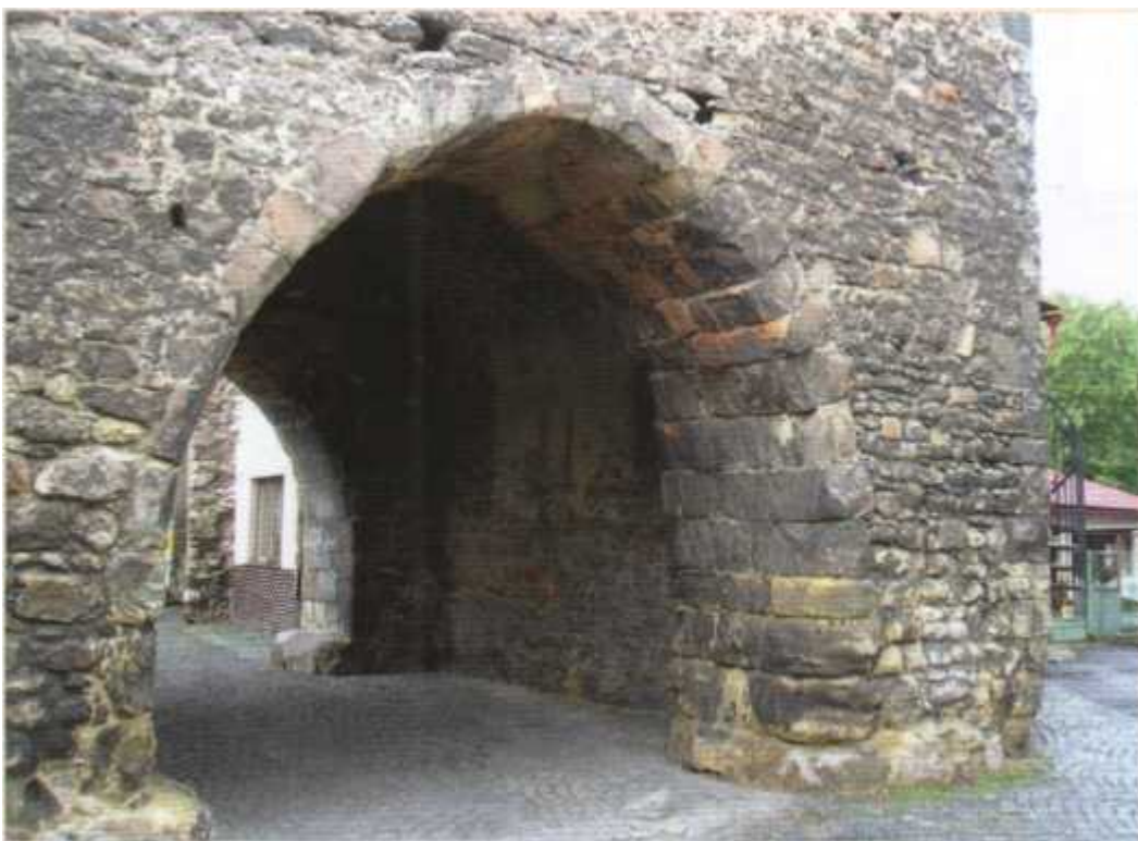
Bělá pod Bezdězem - valený klenutý průjezd Českou bránou, 1. polovina 14. století
